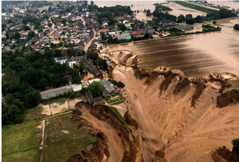
Figure: Erftstadt-Blessem, Germany, July 2021
