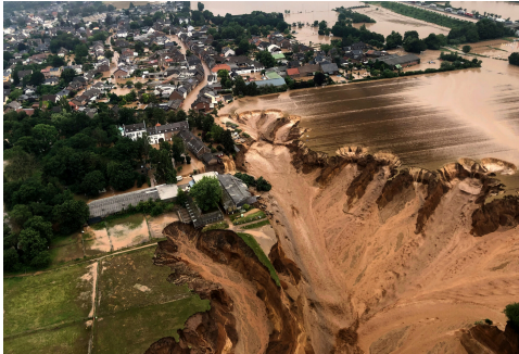
Figure: Erftstadt-Blessem, Germany, July 2021
