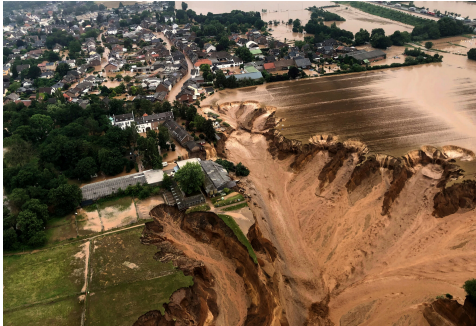
Figure: Erftstadt-Blessem, Germany, July 2021
